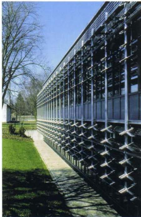
Elementen verwendet. Die im außenliegenden Verbundglas der Lamellen eingebetteten Hologramme konzentrieren die einfallende Sonnenstrahlung auf eine dahinterliegende, mit weißen Siebdruckstreifen versehene Glasscheibe, womit sie dort reflektiert wird. Die Glaslamellen werden der Sonnenlage computergesteuert nachgeführt.
