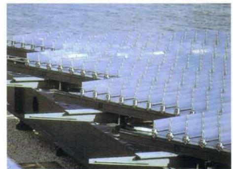
Für das Dach über dem Plenarsaal des Deutschen Bundestages in Bonn, der Architekten G. Behnisch und Partner, 1973–1993, wurden großformatige Lamellen mit Prismenplatten verwendet. Die Platten sind mittels Konsolen an drehbaren Rohren befestigt und werden dem Sonnenlauf nachgeführt. Diese Konstruktion wurde diagonal zum quadratischen Grundriss des Saals angeordnet, um eine effizientere Sonnenschutzwirkung zu erzielen.
